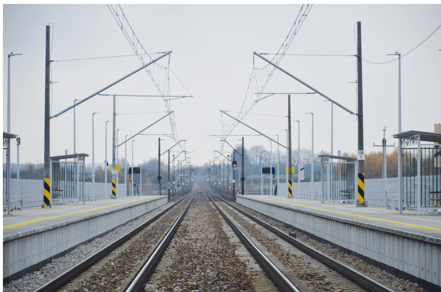
Ryc. 2. Nowy przystanek kolejowy w Rudzie Wielkiej na linii nr 8 Fot. S. Pawłowski, 2023
