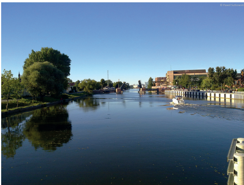
Ryc. 2. Rzeka Elbląg (2013) na wysokości Starego Miasta; w głębi most zwodzony w ciągu ul. Studziennej
