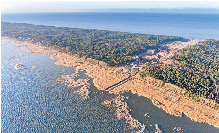
Ryc. 1. Kanał przez Mierzęję Wiślaną w trakcie budowy (2020)
