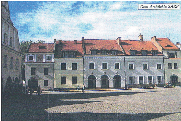
Ryc. 6. Dom Architekta SARP w Kazimierzu Dolnym Źródło: K. de Mezer-Sobotkowska, Z. Sobotkowski, 2012, s. 40
