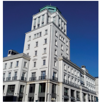
Ryc. 8. Budynek La Piazza Dominanta Placu Ariane, Projekt M. Culot, agencja Arcas Paris Fot. E. Tomaszewska-Taton
